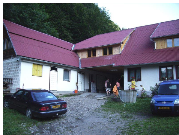
De plaatselijke bouwvakkers zijn bijna klaar als we komen helpen met de verwarming
